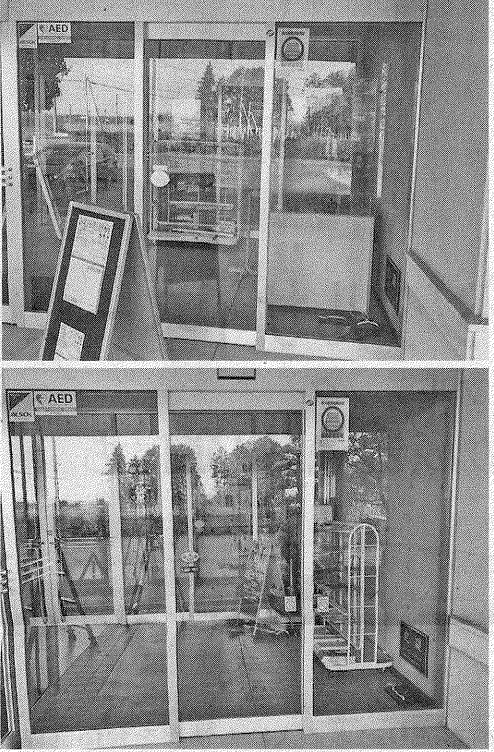
矢吹町文化センターへの施工前(上)と施工後
