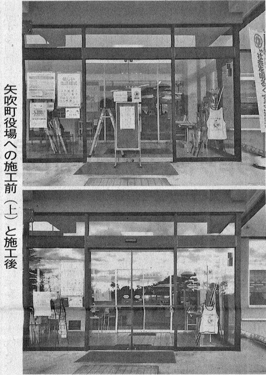
停電時も3時間以上、平常時と変わらない開閉動作が可能
